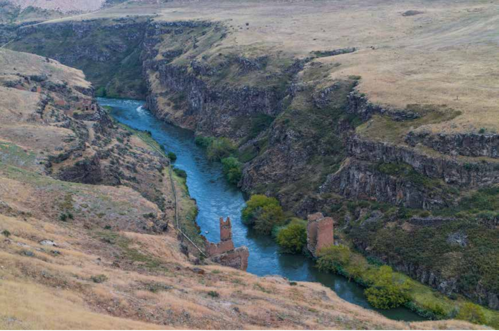
İpek Yolu güzerhâgında bulunan Ani şehrinde Arpaçay üzerinde yer alan köprü. X. yüzyılda inşa edildiği tahmin edilen köprünün kemer kısmı tamamen yıkılmış, günümüze iki yakadaki ayakları ulaşmıştır.
